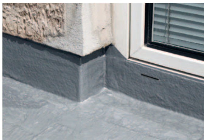
Remates em soleiras com pouca altura, cantos interiores e exteriores
