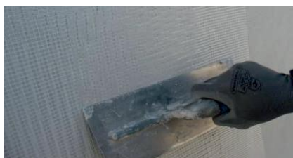
Embebimento da rede de reforço
