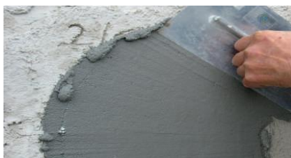
Execução da primeira camada
