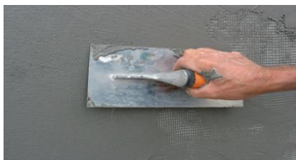
Aplicação da segunda camada
