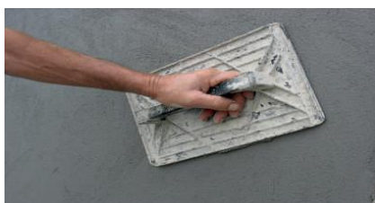
Talochamento da superfície final
