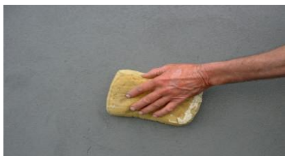
Obtenção do acabamento areado
