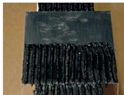
6. Aplicar o Enkolit® sobre a chapa de sobreposição
