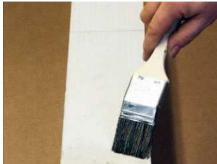
2. Aplicar do Primário Universal 933 no caso de bases soltas
