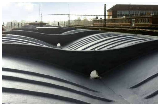
Obras de reabilitação de grande dimensão
