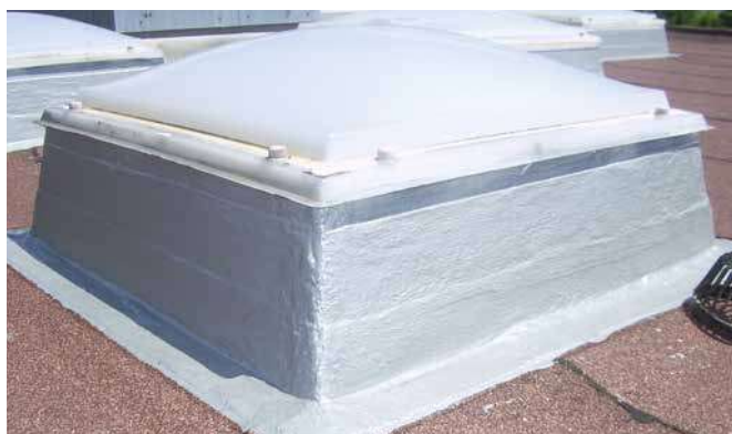
impermeabilização de claraboias
