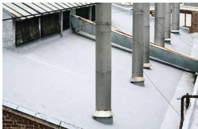
Coberturas industriais com diferentes pontos singulares
