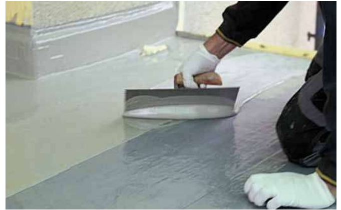
Aplicação de Enketop com uma espátula dentada
