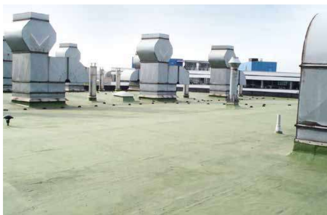
Coberturas industriais com numerosas instalações técnicas
