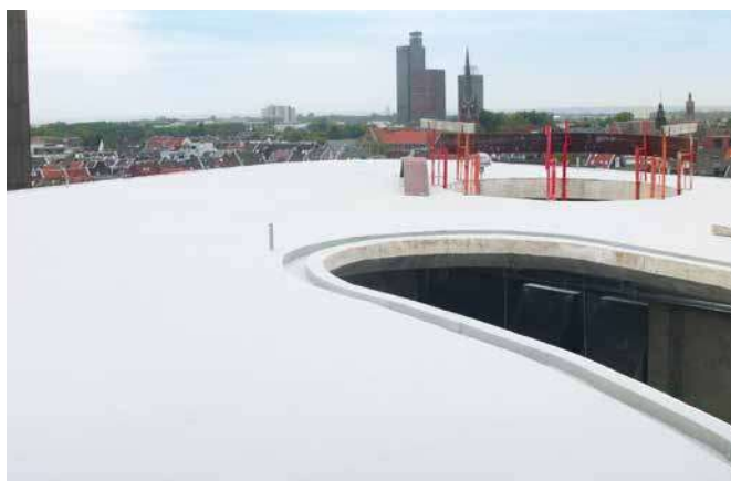
Obras novas de grande dimensão
