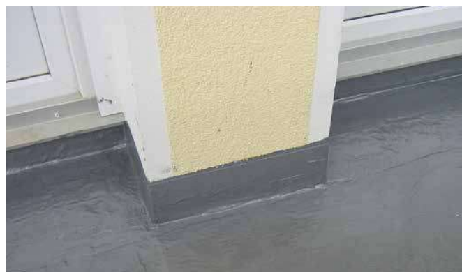
zonas de remate com pouca altura
