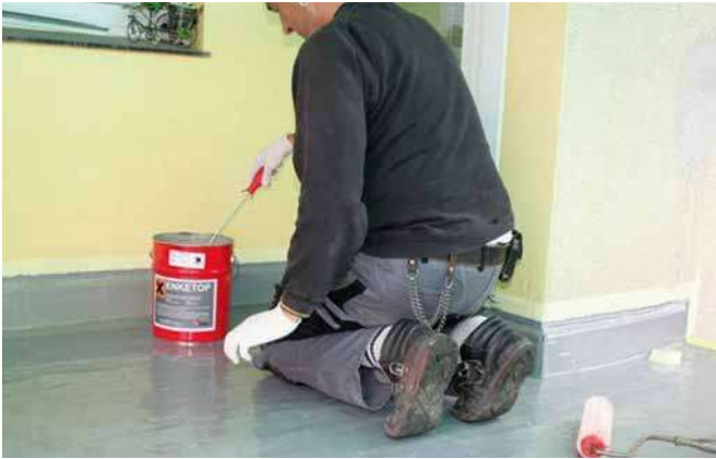
Aplicação de Enketop nos remates de parede
