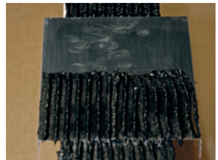
6. Aplicar o Enkolit® sobre a chapa de sobreposição
