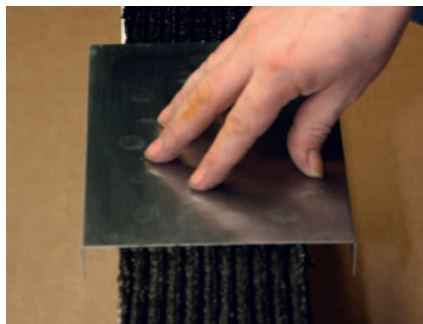
5. Aplicar uma chapa de sobreposição nas juntas (se necessário)
