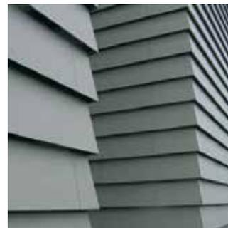
Mientras que las juntas verticales están separadas por 10mm, las juntas horizontales se superponen. Estas pueden superponerse juntas entre sí, o con separadores especiales disponibles por parte de los proveedores de la estructura, que tienen como resultado superposición parcial que proporciona una mayor cobertura.
