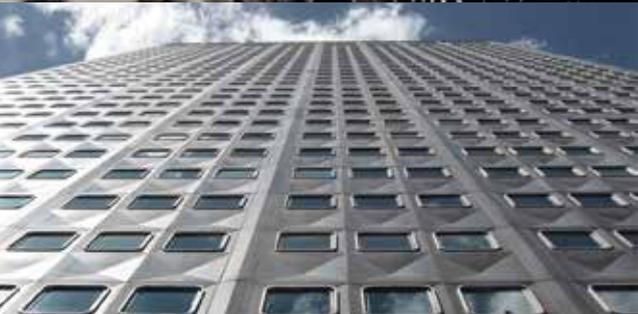
El edificio de Alcoa en Pittsburgh, diseñado por los arquitectos, Harrison y Abramovitz fue uno de los primeros edificios de gran tamaño en utilizar un sistema de revestimiento moderno. El edificio de 30 plantas, fue construido en 1952 y revestido con grandes paneles de aluminio deflectores. La deflexión proporciona resistencia a la penetración del agua. La ventilación se proporcionaba en el espacio de aire entre el revestimiento y la pared principal para secar cualquier humedad.
