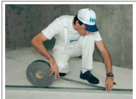
A fita de isolamento é imprescindível para assegurar um melhor desempenho acústico das paredes. Sempre utilizar fitas com largura compatível com os perfis.
