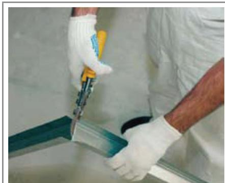
Utilizar a tesoura para corte de perfis metálicos.
