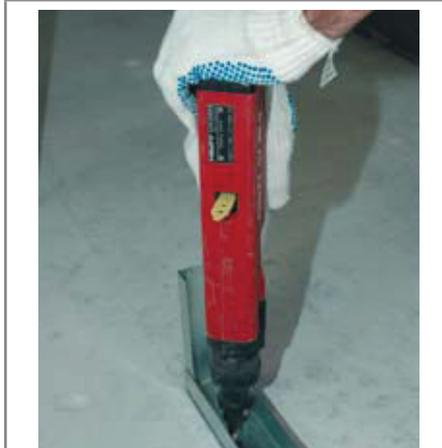
A fixação deverá ser feita no máximo a cada 1.000 mm sendo que nas aberturas de vãos de portas deve ser feita uma em cada extremidade. Executar as emendas das guias sempre de topo, nunca sobrepô-las. Preferencialmente, o piso deve estar nivelado e acabado.
