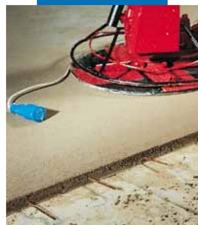
Acabamento superficial com helicóptero
