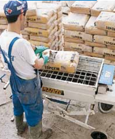
Empasto de Topcem com misturador em c6clea
