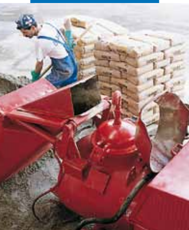
Empasto de Topcem com instala76o autom6tica de bombagem
