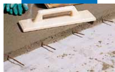
Particularidade da betonilha em Topcem com ferros de juntas de betonagem
