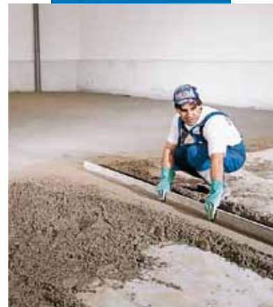
Formação de guias de nivelamento
