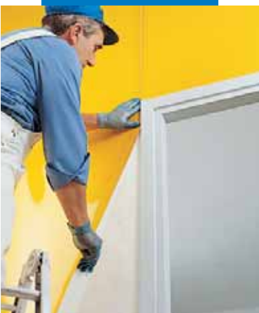
Aplicação de revestimento de paredes em telas com o Adesilex MT32
