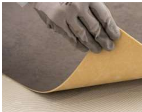
Aplicação de pavimento de base poliuretânica com Ultrabond Eco V4 Evolution
