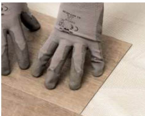
Aplicação de LVT com Ultrabond Eco V4 Evolution
