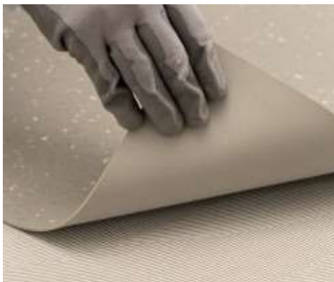
Aplicação de borracha com Ultrabond Eco V4 Evolution
