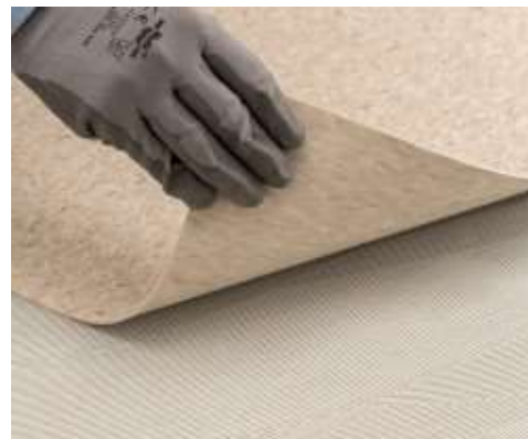
Aplicação de PVC homogéneo com Ultrabond Eco V4 Evolution
