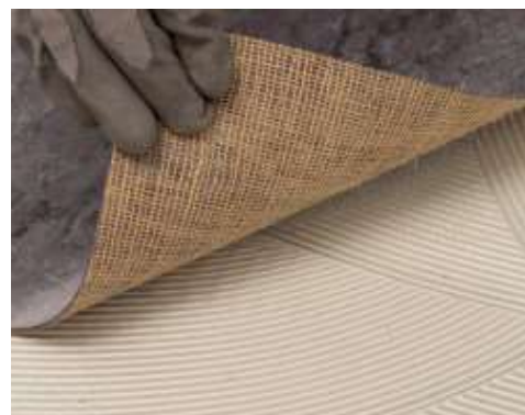
Aplicação de linóleo com Ultrabond Eco V4 Evolution
