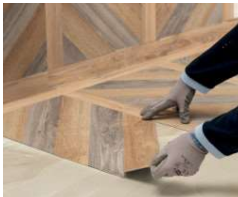
Aplicação de LVT modular com Ultrabond Eco V4 Evolution
