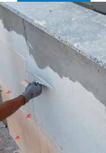
Assentamento em fachada exterior, aplicação do adesivo no suporte
