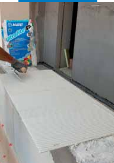
Aplicação do adesivo no reverso do ladrilho
