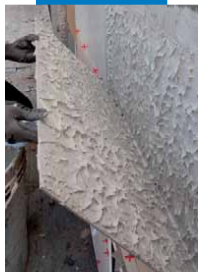
Verificação da molhagem total no reverso do ladrilho no assentamento em fachada no exterior
