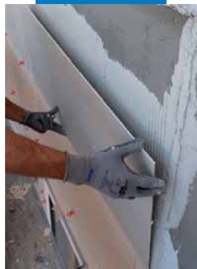
Aplicação do ladrilho em grés porcelânico fino em fachada no exterior
