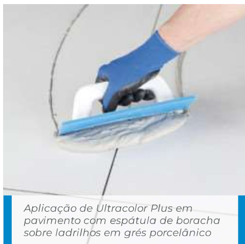
Aplicação de Ultracolor Plus em pavimento com espátula de borracha sobre ladrilhos em grés porcelânico efeito madeira
