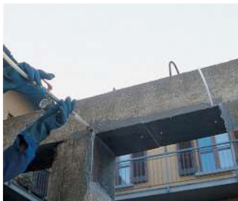
Placagem de traves mediante injeção de Epojet
