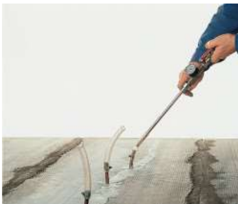
Reparação de estrutura horizontal com injeção de Epojet
