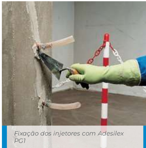
Injeção de Epojet no pilar fissurado
