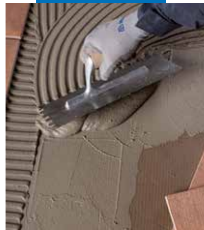
Assentamento de ladrilhos com Elastorapid
