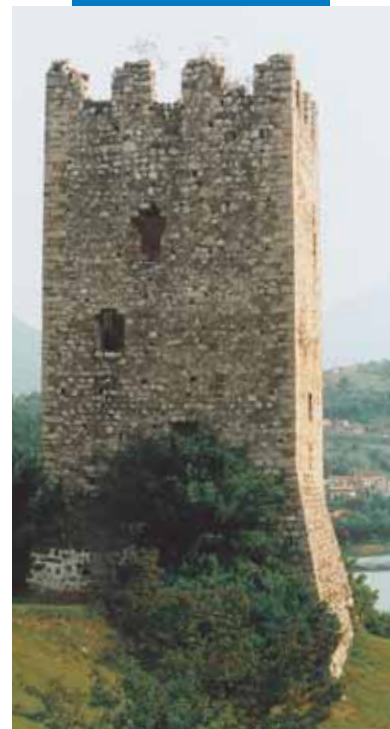
Torre de S. Floriano consolidada através de injeção de Mape-Antique I
