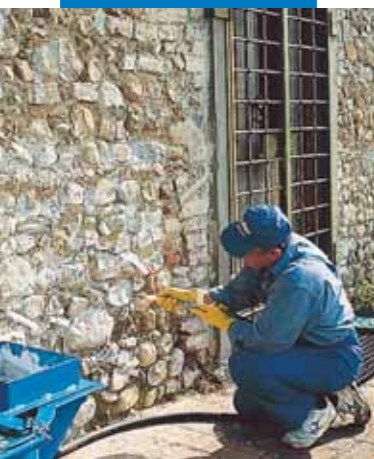
Injecção de consolidação de Mape-Antique I
