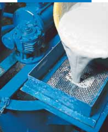
Enchimento da bomba de injeção com Mape-Antique I
