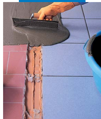
Nivelamento de pavimentos velhos com Adesilex P4
