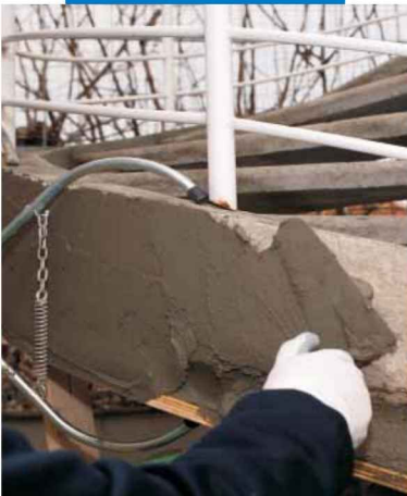
Aplicação com colher de pedreiro do Mapegrout 430
