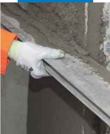
Nivelar à régua do Mapegrout 430
