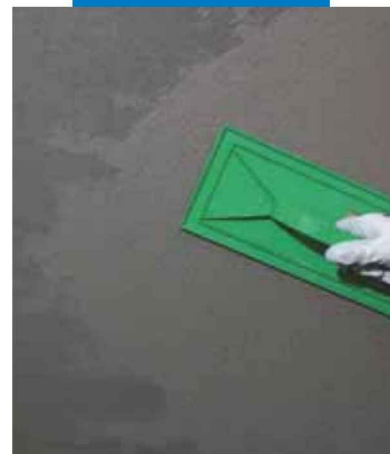
Afagamento à talocha do Mapegrout 430
