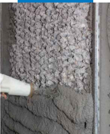
Aplicação com máquina de projetar do Mapegrout 430
