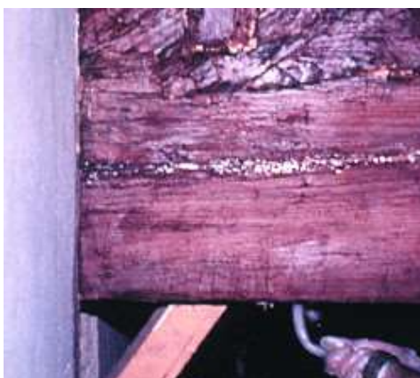
Injeção de Mapewood Gel 120
