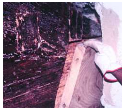
Re-perfilamento das vigas
