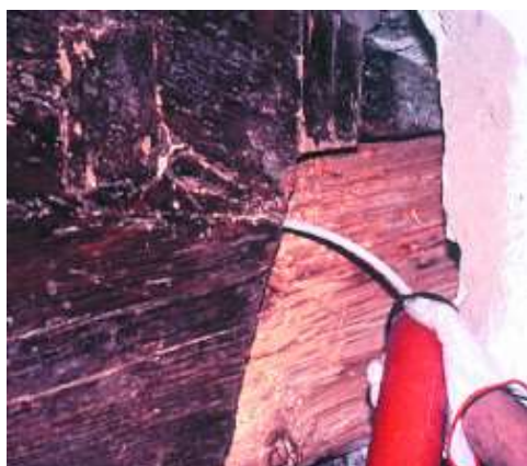
Injeção de Mapewood Gel 120
