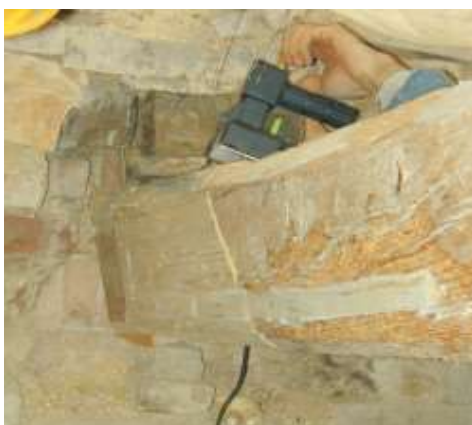
Lixagem das vigas
