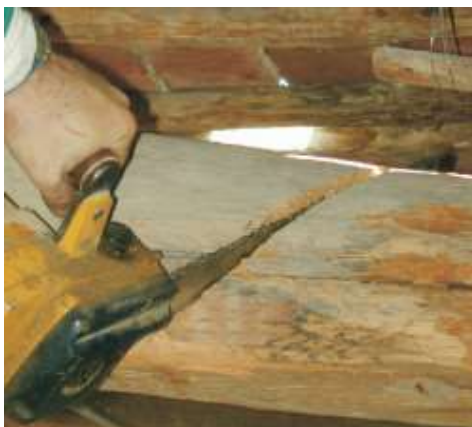
Corte da viga
