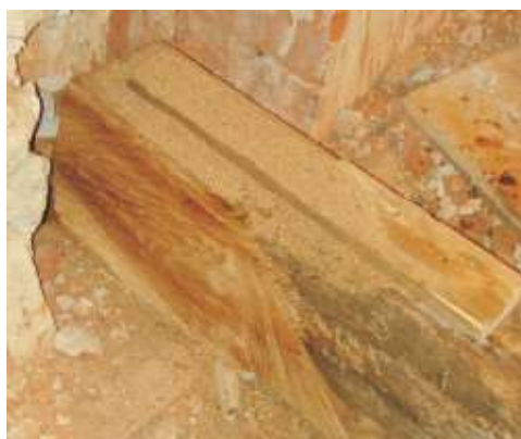
Elemento estrutural antes da aplicação de Mapewood Primer 100
