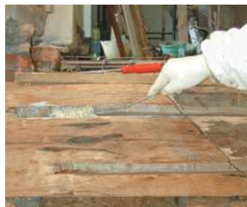
Aplicação de Mapewood Primer 100 mediante escovilhão
