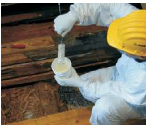
Fase aplicativa de Mapewood Primer 100
