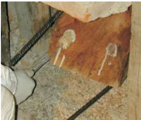
Aplicação de Mapewood Primer 100 mediante escovilhão
