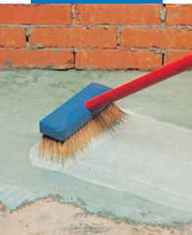
Aplicação de betonilha cimentícia aderente aditivado com Planicrete
