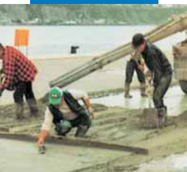
Betonilhas cimentícias externas aditivadas com Planicrete
