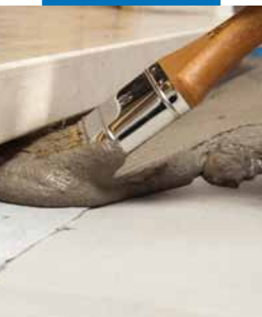
Aplicação de Mapeband SA em pontos de acesso difícil como debaixo da soleira
