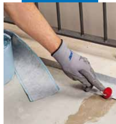
Aplicação de Mapeband SA nas arestas
