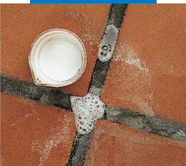
Limpeza de eflorescências
