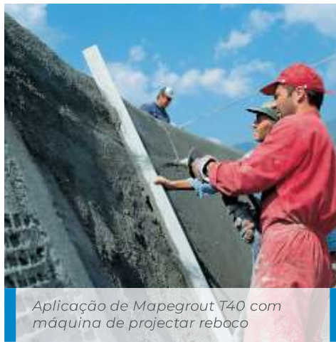
Acabamento do Mapegrout T40 com talocha
