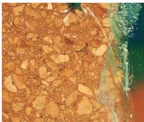
Remoção do graffiti mediante escovagem e lavagem
