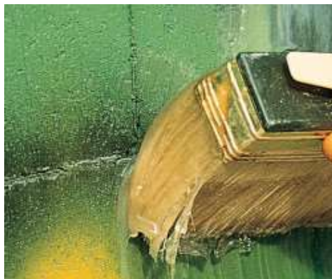
Aplicação de WallGard Graffiti Remover Gel a pincel
