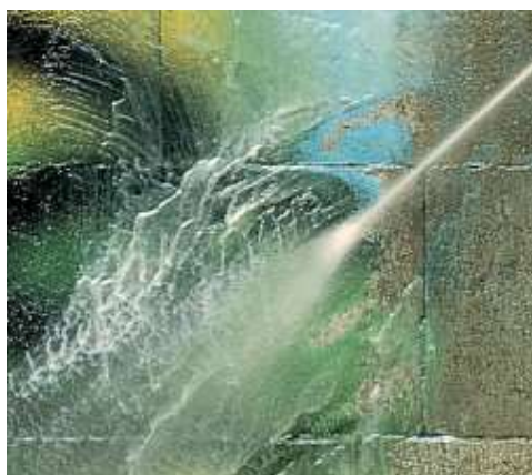
Lavagem com água sob pressão
