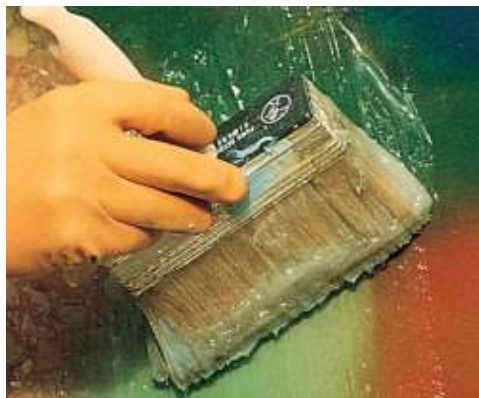
Aplicação de WallGard Graffiti Remover Gel sobre pedra natural
