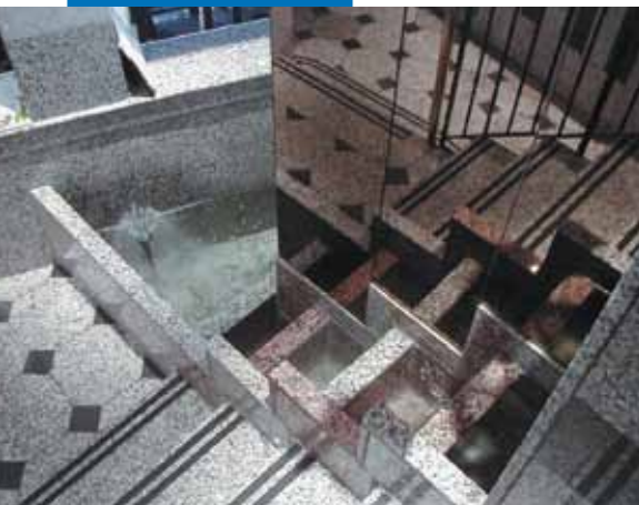
Exemplo de assentamento de granito em paredes e pavimentos com Keraquick + Latex Plus - Caesaris Palace em Merseyside - Liverpool (Grã-Bretanha)
