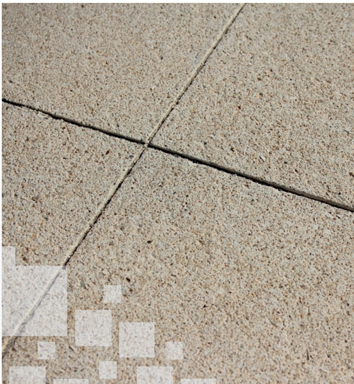
Pormenor de junta no pavimento Scala.
