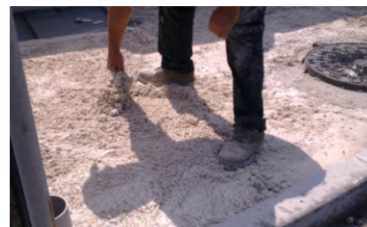
3. Colocação da argamassa SCALA DECOR
