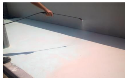
5. Aplicação do desativante de superfície SCALA AD 31 ou SCALA AD 32 para acabamento desativado
