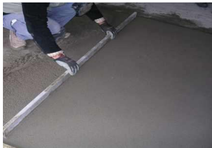
Regularização com régua metálica
