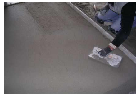
Talochamento da superfície final
