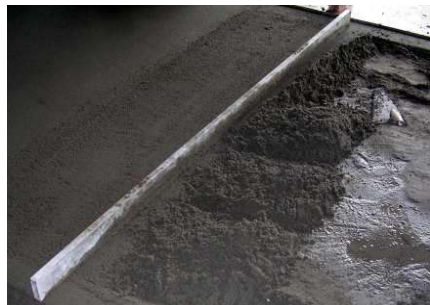
Colocação da argamassa
