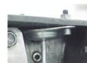
Abombamiento Suela M6
