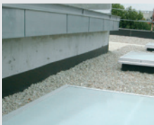
Impermeabilização de remates em elementos verticais com TexTop .
