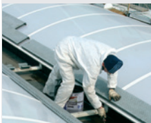
Caleira impermeabilizada com TexTop .
